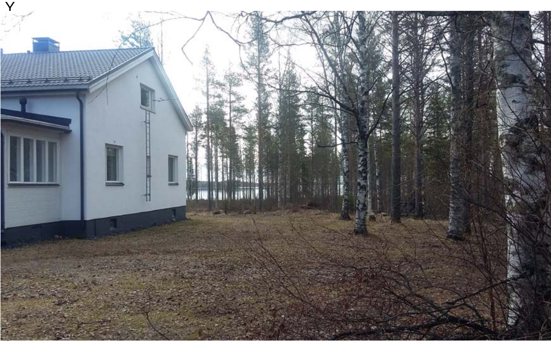
Villa Apukka joka on entinen Tutkimusaseman johtajan asunto, taustalla Olkkajärvi.
